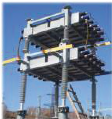
Сборка БСК на объекте эксплуатации
