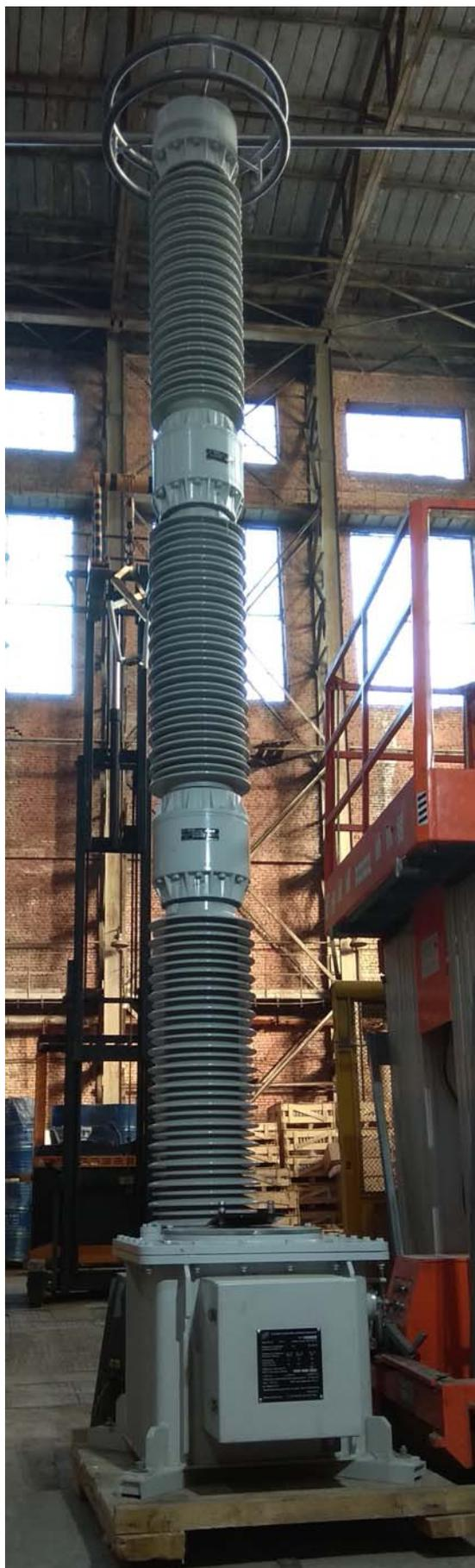
Рисунок 4 - Внешний вид трансформаторов ЕТН-500 УХЛ11
