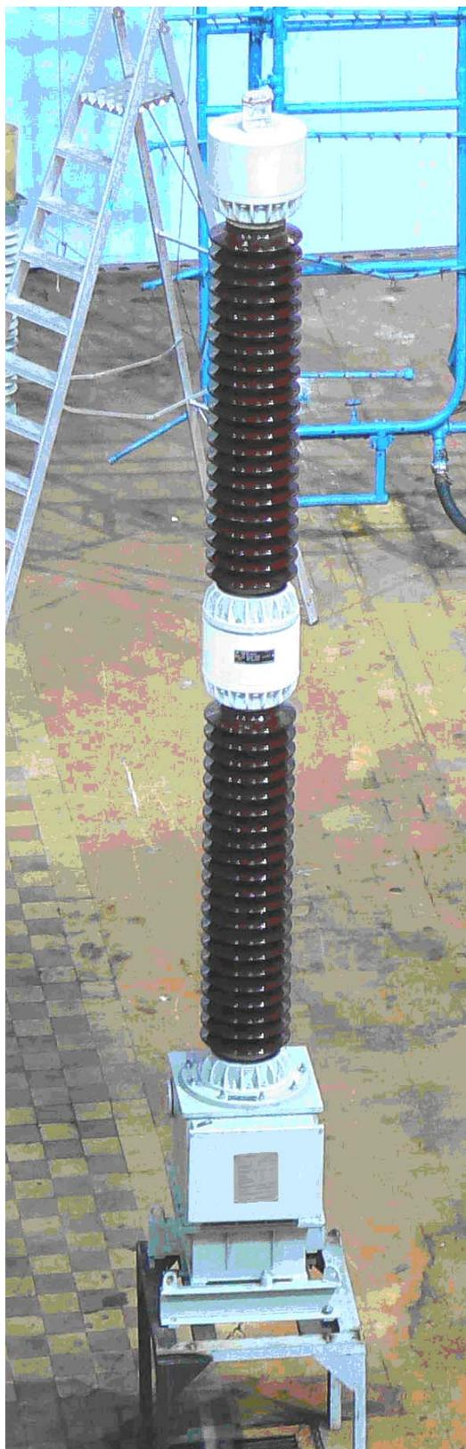
Рисунок 2 - Внешний вид трансформаторов ЕТН-220 УХЛ1
