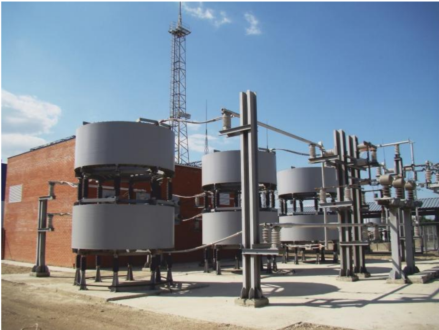
Статический тиристорный компенсатор реактивной мощности модульного исполнения с системой воздушного охлаждения.
