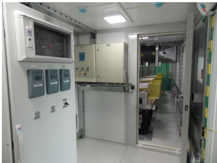
Статический тиристорный компенсатор реактивной мощности модульного исполнения с системой воздушного охлаждения.
