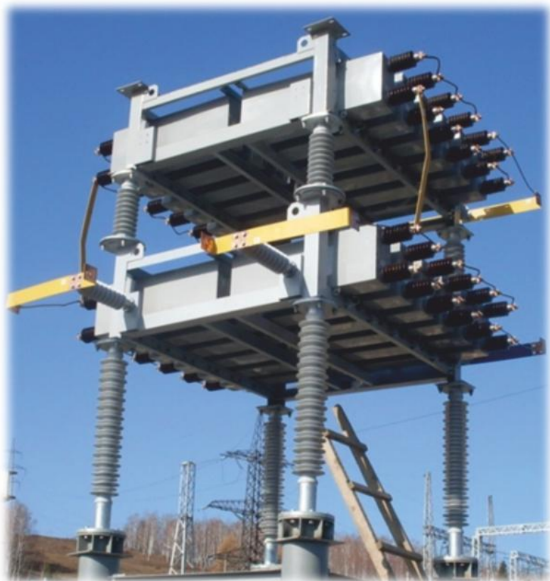
Сборка БСК на объекте эксплуатации
