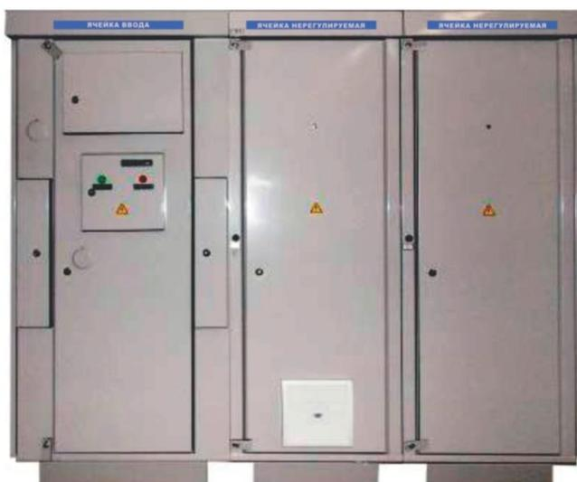
Установки предназначены для повышения коэффициента мощности ( $\cos \varphi$ ) электроустановок промышленных предприятий и распределительных сетей напряжением 6-10 кВ частоты 50 Гц с фиксированным энергопотреблением в часы максимальных и минимальных нагрузок в режиме работы узла энергосети.
